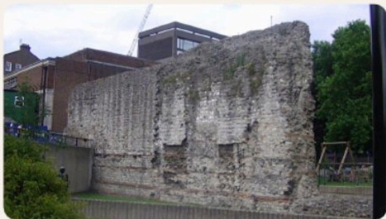
塔丘一帶仍能看到羅馬倫敦城牆的一部分。下層可見羅馬時代的石材與磚帶，上方則疊著後世修補與增建。
